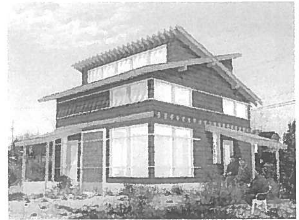
Vue d'ensemble d'une maison
