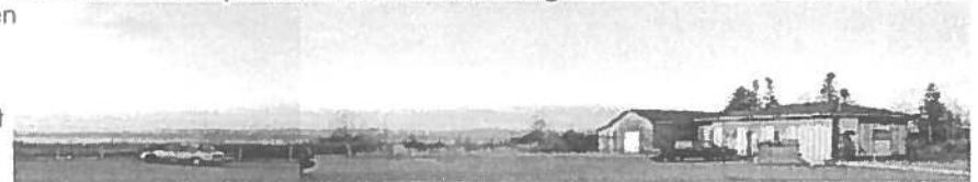
Vue du bout de l'avenue Dequen ; situation actuelle
