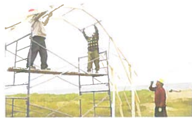
04 - Montage de la structure sur le terrain.
