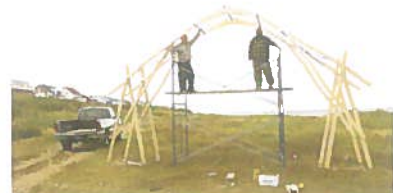
05 - Montage de la structure sur le terrain.
