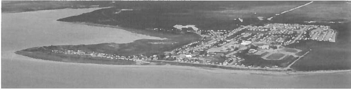
Figure 1 : Photographie aérienne de Pessamit, source : www.tetauan.org
