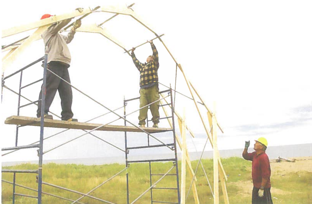
Pose d'un module de faîte. Pessamit, Juillet 2012. Source : De l'auteur.
