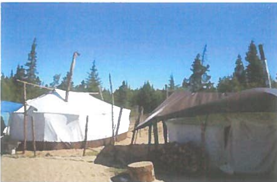
Figure 18 : Tente circulaire à structure extérieure.
