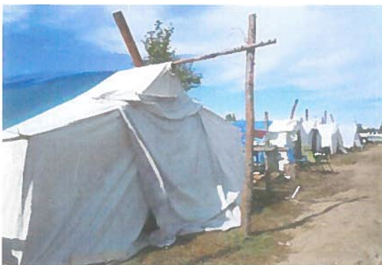
Figure 14 : Tente à structure de faite intérieure.
