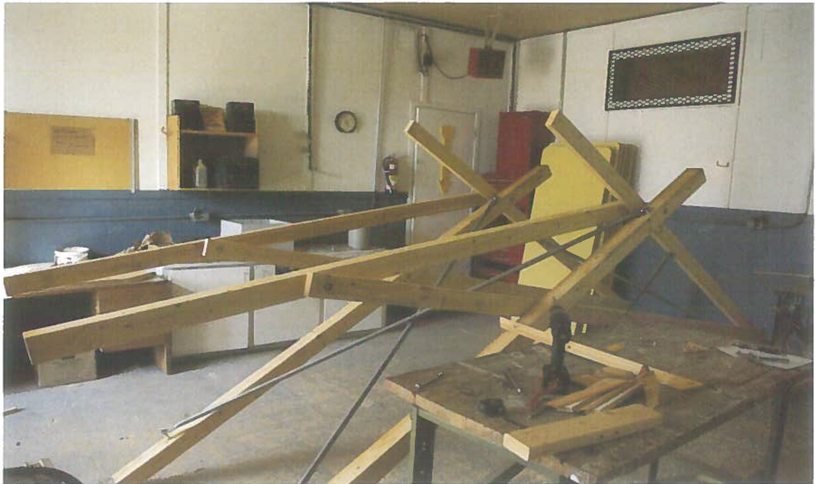
Construction et assemblage d'élément en atelier. Pessamit, Juillet 2012. Source : De l'auteur.
