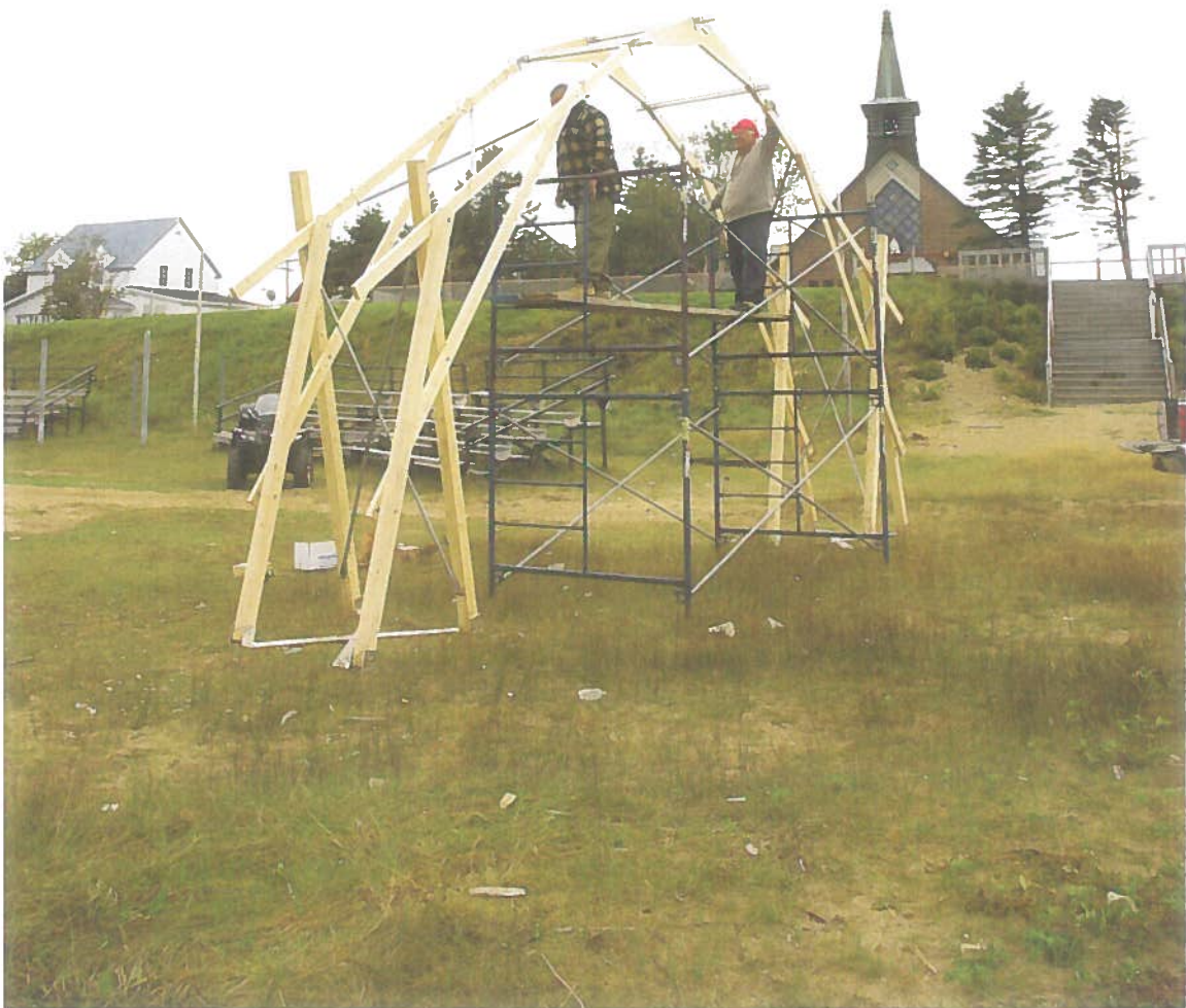
Une arche complète de la structure assemblée. Pessamit. Juillet 2012. Source : De l'auteur.
