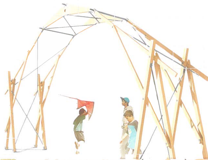
06 - Montage des poutres principales de la structure.
