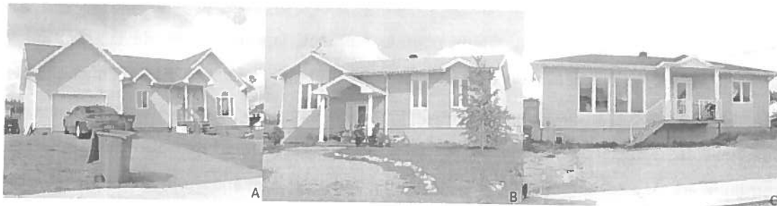
Figure 79 : Bungalows situés dans le secteur est du village, Oujé-Bougoumou Source : Caroline Morneau, juillet 2009
