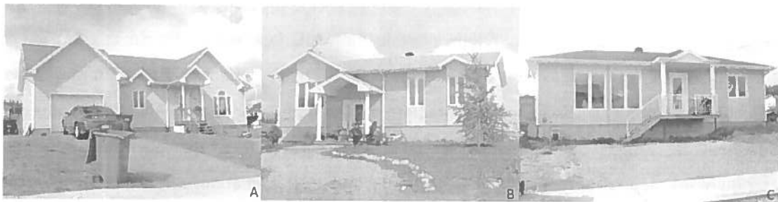
Figure 79 : Bungalows situés dans le secteur est du village, Oujé-Bougoumou Source : Caroline Morneau, juillet 2009
