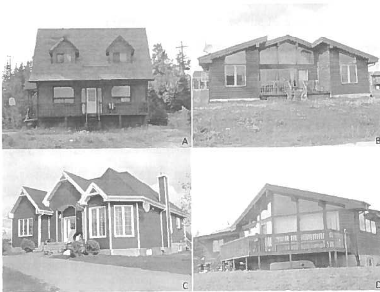
Figure 80 : Habitations unifamiliales situées dans le secteur est du village, Ujé-Bougoumou
