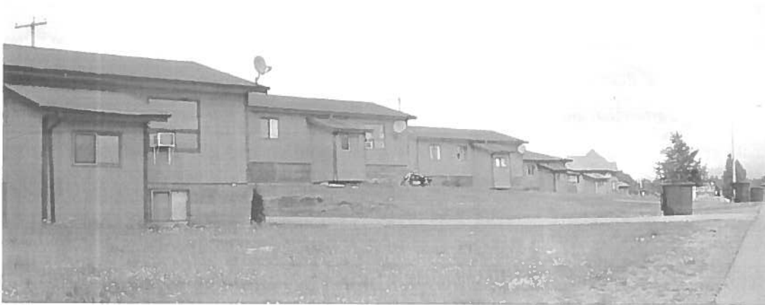
Figure 84 : Alignement des maisons avec entrée au sud-est, Oujé-Bougoumou Source : Caroline Morneau, juillet 2009
