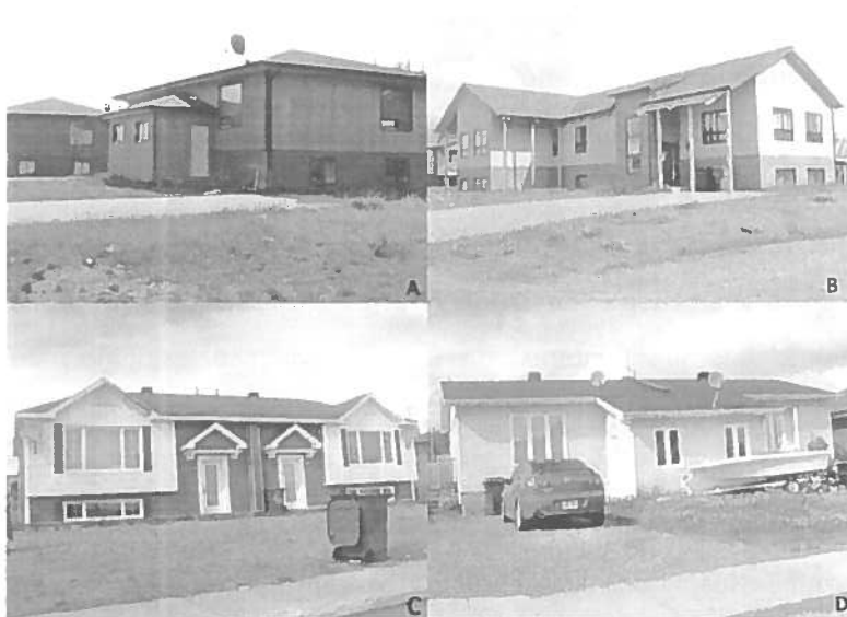
Figure 82 : Habitations unifamiliales semi-détachées, Oujé-Bougoumou
